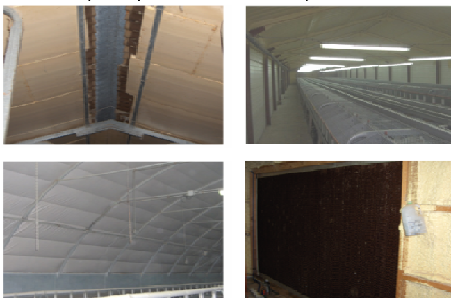
Figura 4: Exemplos de isolamento (placas de esferovite – esq. sup.; chapas sandwich – dir. sup.; lona – esq. inf.; poliuretano – dir. inf.)
