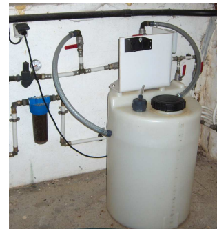
Figura 22: Doseador de tratamentos na água
