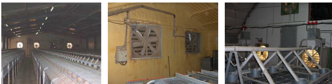
Figura 5: Ventilação dinâmica por depressão
