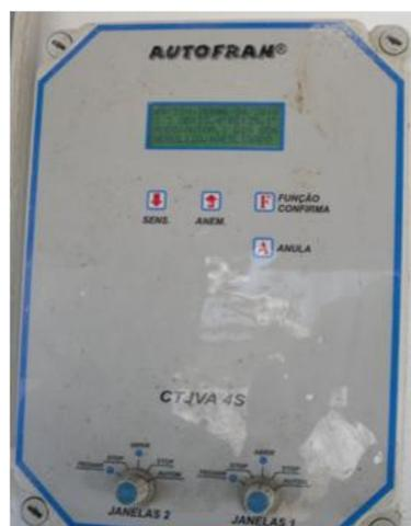
Figura 17 - Sistema de controlo automático de janelas (Foto própria, 2010).
