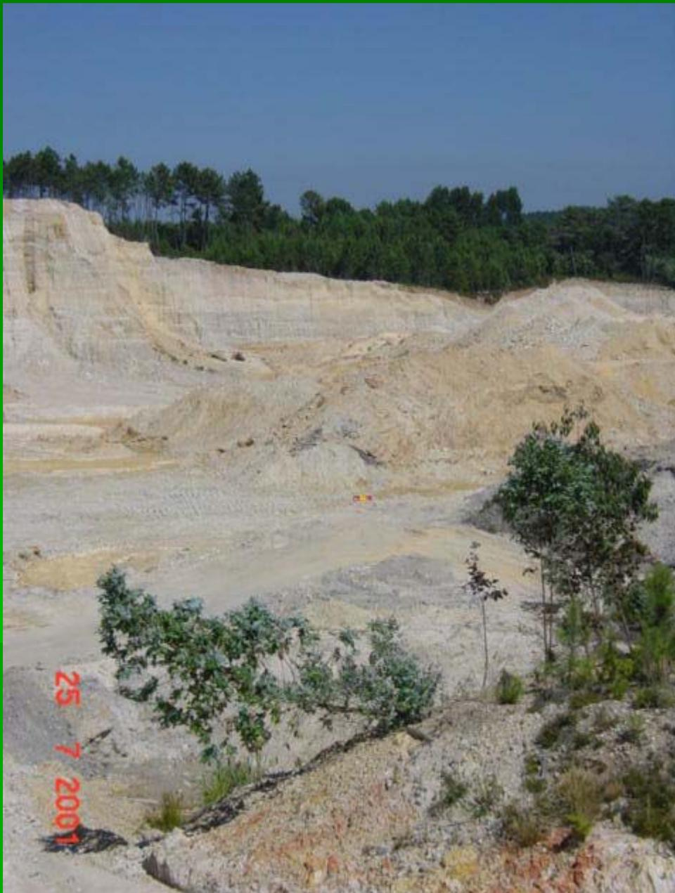
**Utilização de material considerado estéril, por estar carregado de óxidos de ferro, para nivelamento das áreas já escavadas e como substrato para a colocação de terras Vegetais.**
