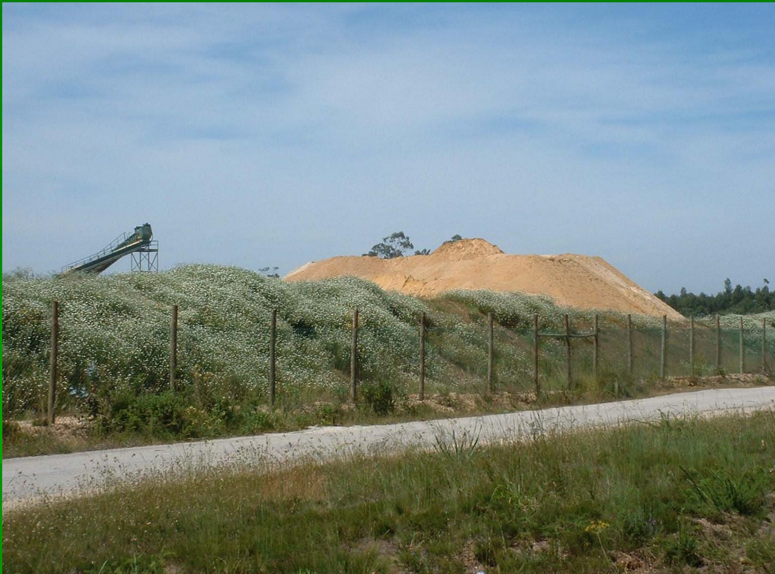
**Construção e tratamento com hidrosementeira de um talude camuflador da zona de trabalhos, em zonas contíguas a vias rodoviárias. Vedação da propriedade para impossibilitar o acesso às áreas de exploração e ao E.I. e assim evitar acidentes.**
