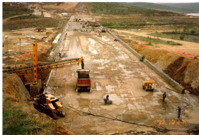
Figura 21: Método do betão compactado com cilindro (Fonte: LNEC, 2016).
