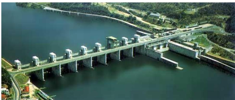
Figura 17: Eclusa de Navegação, ao lado direito do corpo de barragem (Fonte: APA, 2016).
