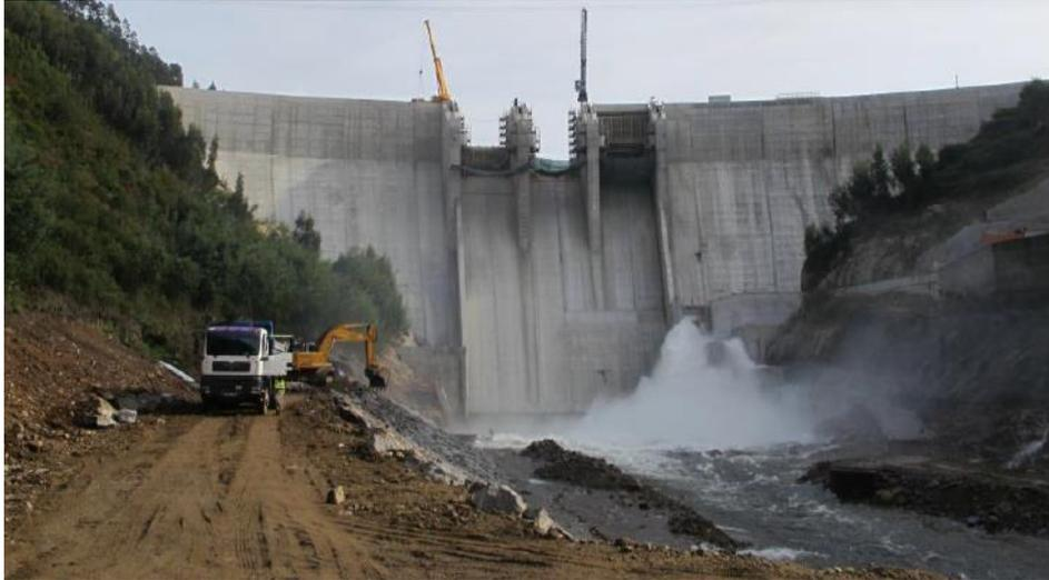
*Figura 40: Descarregador de Fundo – Barragem de Ribeiradio Ermida (Fonte: COBA).*
