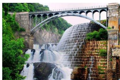
d) Descarregador em blocos de betão pré-fabricado.
