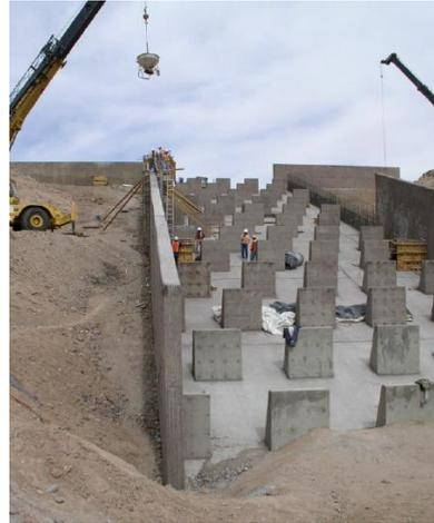
Figura 36: Dissipação por blocos (Fonte: Figueiredo, N., 2010).
