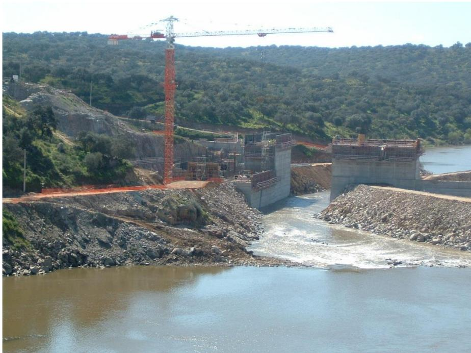
*Figura 19: Obra de derivação de caudal - Barragem de Pedrogão (Fonte: FLE, 2016).*
