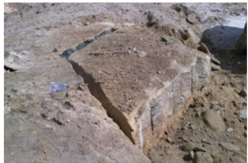
Exemplo de utilização de pólvora negra e cordão detonante para destacar uma porção do maciço.
