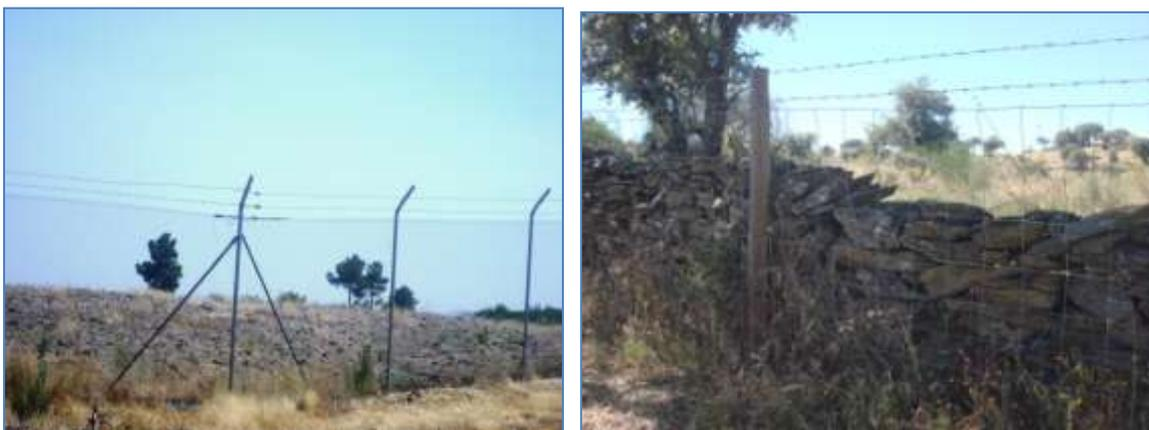
**Figura 16.** Tipo de cercado utilizado para o parcelamento das explorações: à esquerda, cercado tipo cinegético (altura superior a 2,2m) e à direita, cercado tipo pecuário (1,5m de altura). (fotografias de autor).
