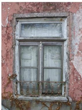
**Figura 50:** Janela com duas folhas de abrir, com bandeira
