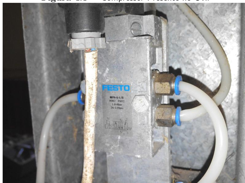
Figura 4.4 – Válvulas para a Abertura e Fecho da Cancela
