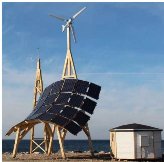
**Figura 4.9** – Exemplo dum sistema híbrido de carregamento de veículos (InnoVentum, 2017).
