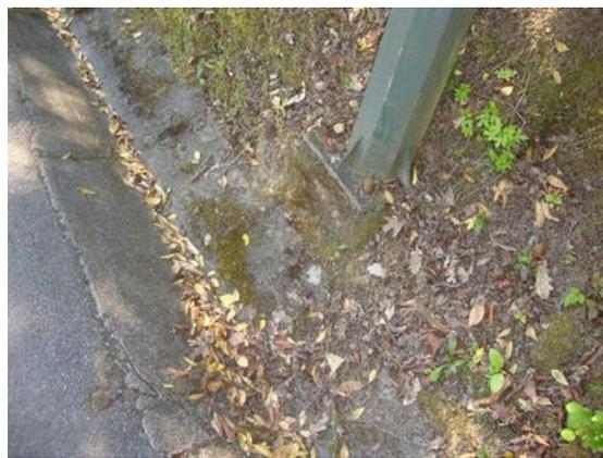
*Figura 43. Falta de acabamento/remates de Construção*
