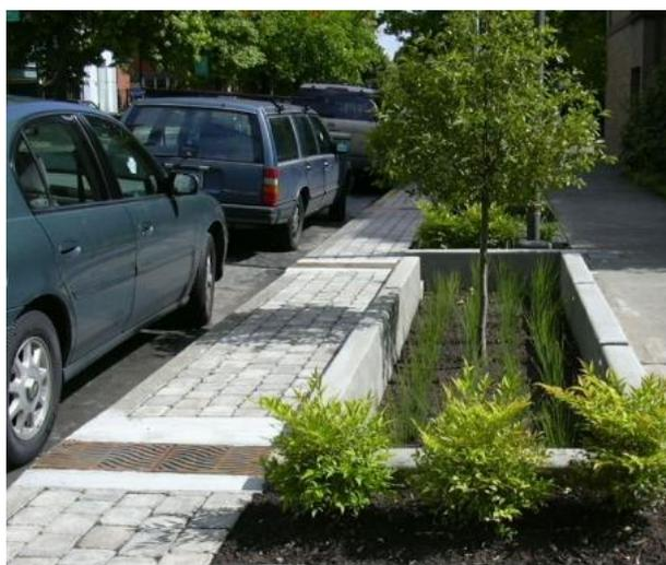
Figura 26 - Exemplo de um sistema de biorretenção (Fonte: Cobec)
