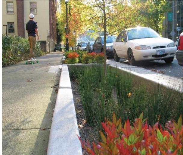
Figura 27 - Exemplo de um sistema de biorretenção (Fonte: Soluções para cidades)
