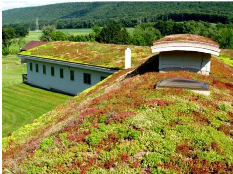
Figura 31 - Exemplo de uma cobertura extensiva (Fonte: Pinto, 2014)
