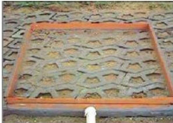
*Figura 18 - Pavimento poroso composto por blocos de betão com orifícios verticais (Fonte: Santos, 2010)*
