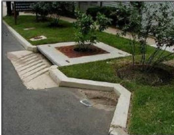
*Figura 23 - Caldeira com sumidouro a montante (Fonte: Swartz e Belan, 2010)*
