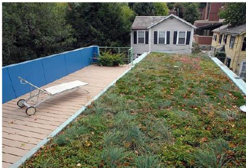
*Figura 32 - Exemplo de uma cobertura semi-intensiva (Fonte: Palha, 2016)*
