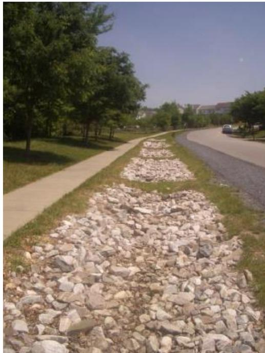
*Figura 14 - Exemplo de uma trincheira de infiltração (Fonte: Lourenço, 2014)*
