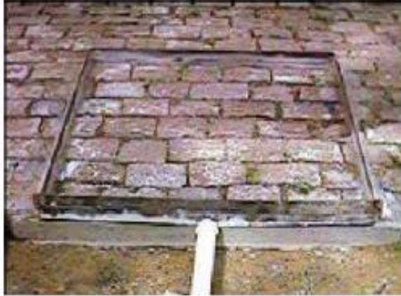
*Figura 17 - Pavimento poroso constituído por paralelepípedos de granito (Fonte: Santos, 2010)*
