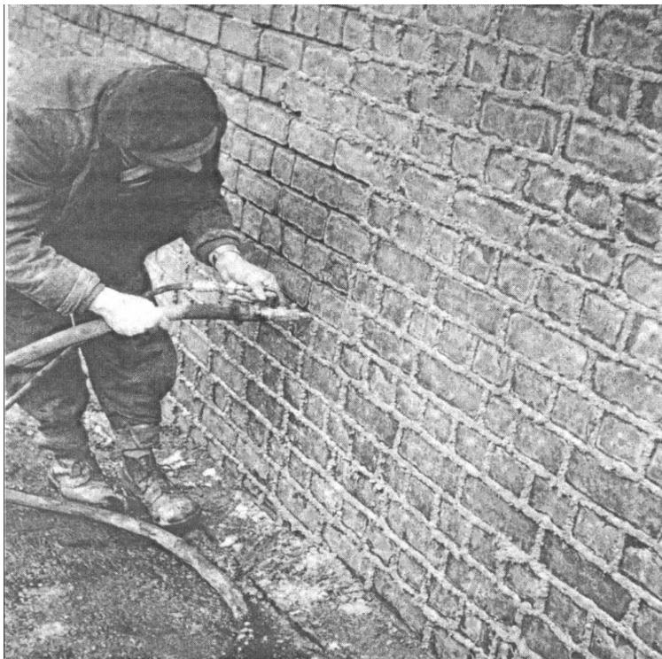
**Figura 3.2** - Operação de substituição da argamassa das juntas
