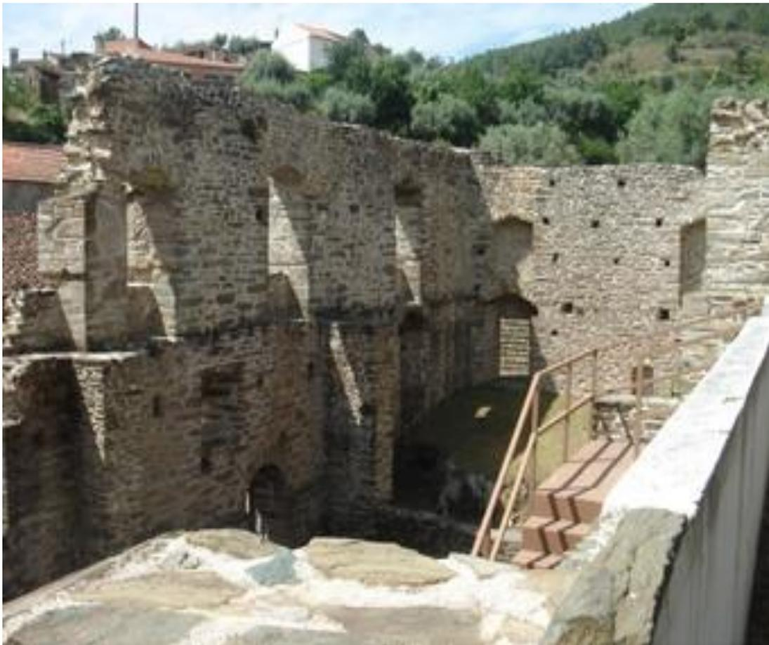
**Figura 3.6** – Aspecto final de refecimento de juntas, Fábrica de Seda, Chacim, Macedo de Cavaleiros.
