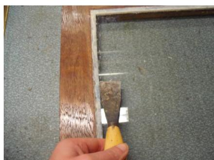
Fig. 100 – Remoção de excessos de massa de vidraceiro
