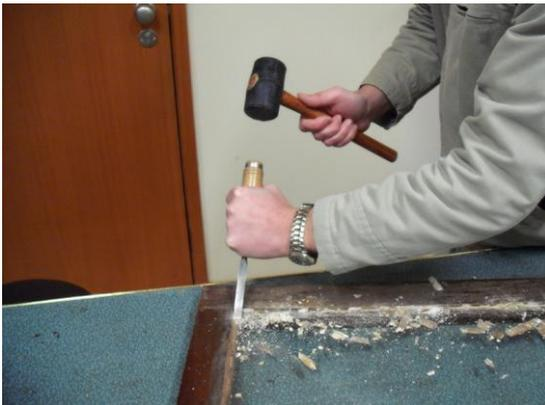
Fig. 90 – Remoção da massa de vidraceiro (GOMES, A.M.; 2009)
