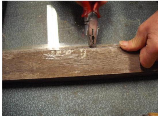
Fig. 91 – Remoção dos pontos de vidraceiro (GOMES, A. M.; 2009)
