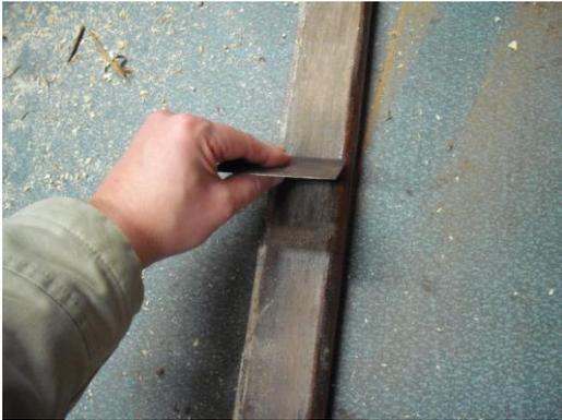
Fig. 92 – Raspagem da superfície (GOMES,A.M.;2009)
