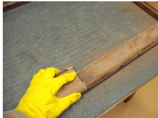
Fig. 92 – Lixagem da madeira(GOMES,A.M.; 2009)
