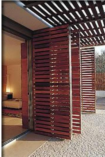
Fig. 13 – Portadas exteriores de madeira
