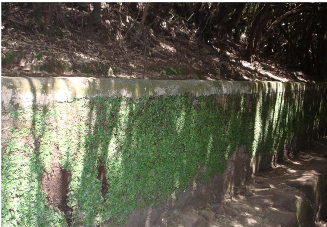
**Figura 101: Fixação de musgos e líquens no muro do canal das 25 Fontes.**
