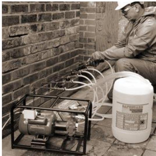
Fotografia 3.6 - Injecção de impermeabilizante com recurso a uma bomba injectora.
