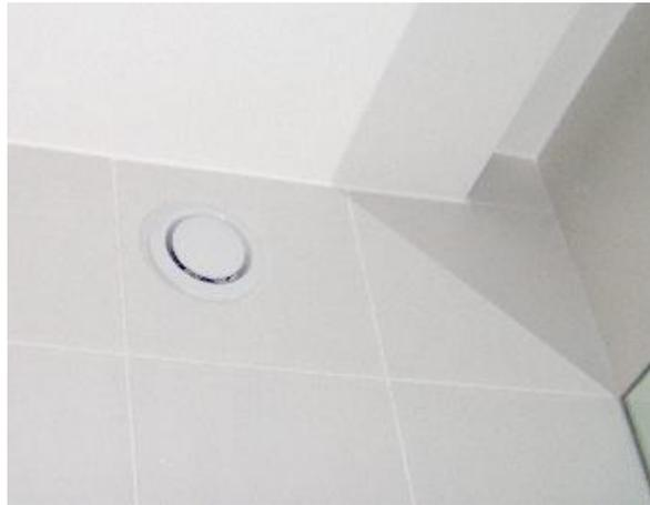
Fotografia 3.5 - Abertura circular de extracção de ar colocada na zona superior da parede.
