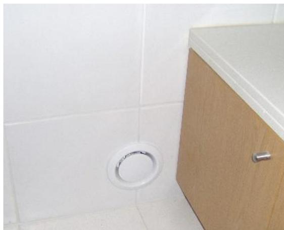
Fotografia 3.4 - Abertura circular de entrada de ar colocada na zona inferior da parede.
