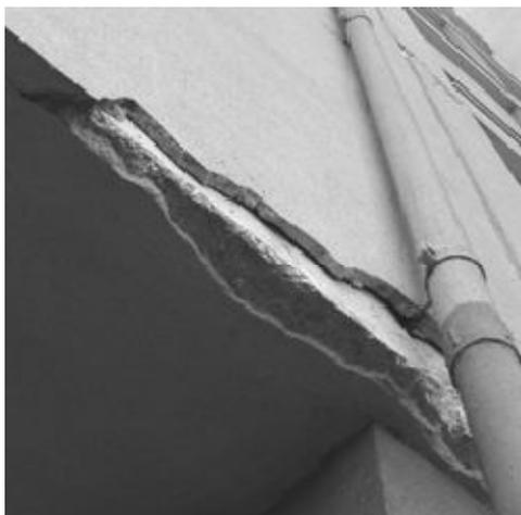
**Figura 10:** Destacamento de reboco rígido.
