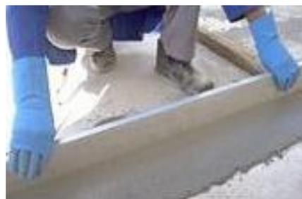
**Figura 9:** Argamassas para regularização de pavimentos. Fonte: [1]
