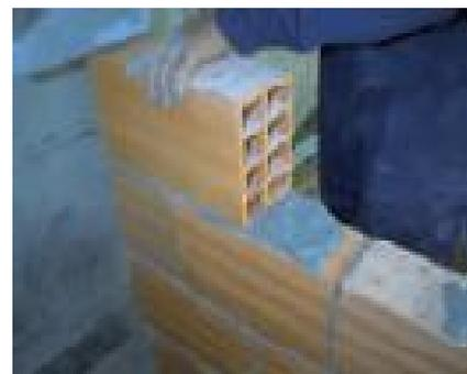
**Figura 5:** Argamassa de alvenaria (união de estruturas). Fonte: [1]
