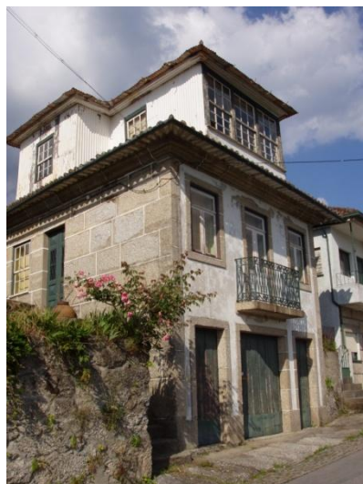
Figura 2.2 – Vista exterior do edifício usado como caso de estudo (Setembro de 2011)
