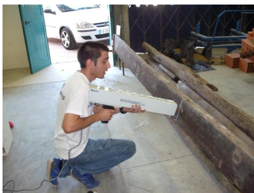
Figura 3.15 – Utilização do resistógrafo (Julho de 2012)
