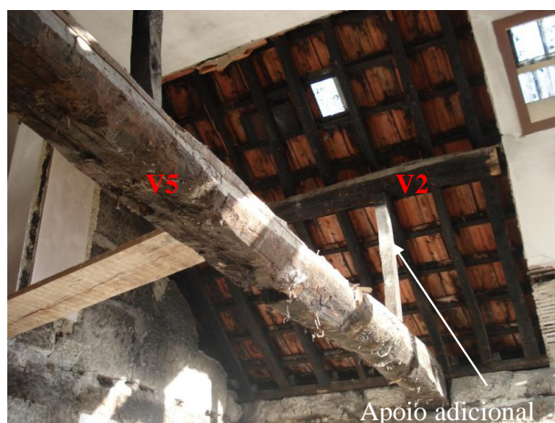
Figura 2.11 – Apoio adicional da viga V2 (Setembro de 2011)
