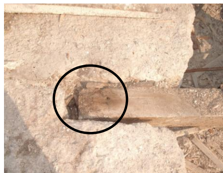
b) Apoio da viga V6
