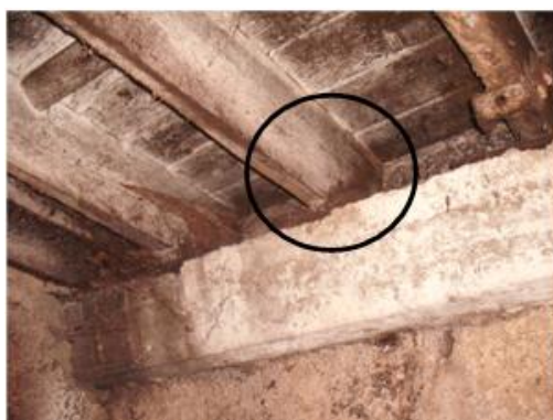
Figura 5.6 – Apoio das vigas V7 no cachorro (Setembro de 2011)
