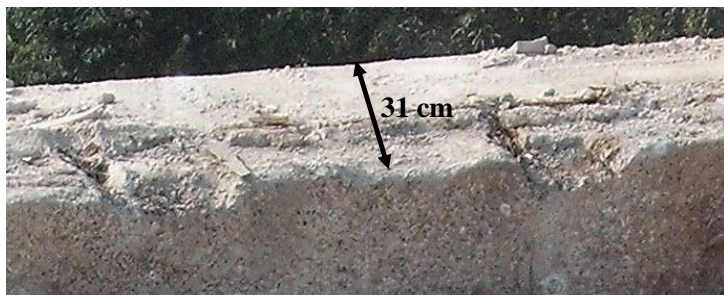
Figura 2.8 – Parede resistente de alvenaria de granito da região (Setembro de 2011)
