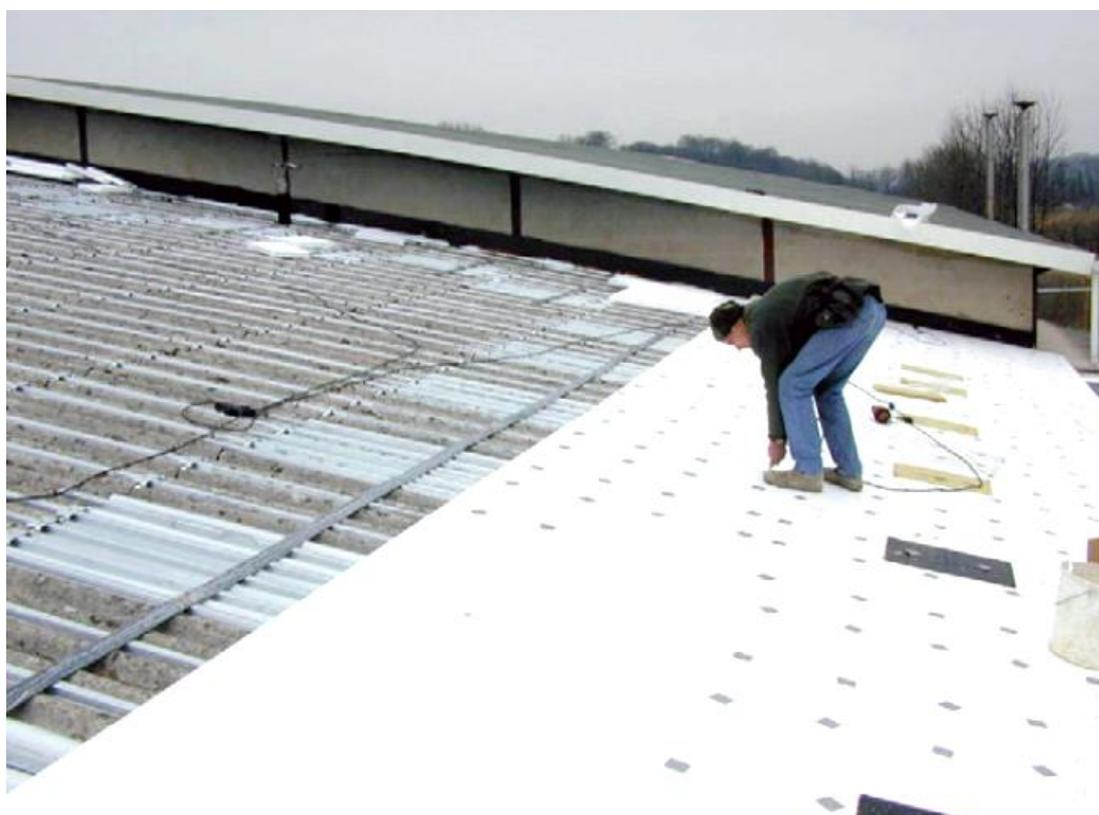
*Fotografia 72 – Colocação das placas de isolamento térmico (Pombo, 2014)*
