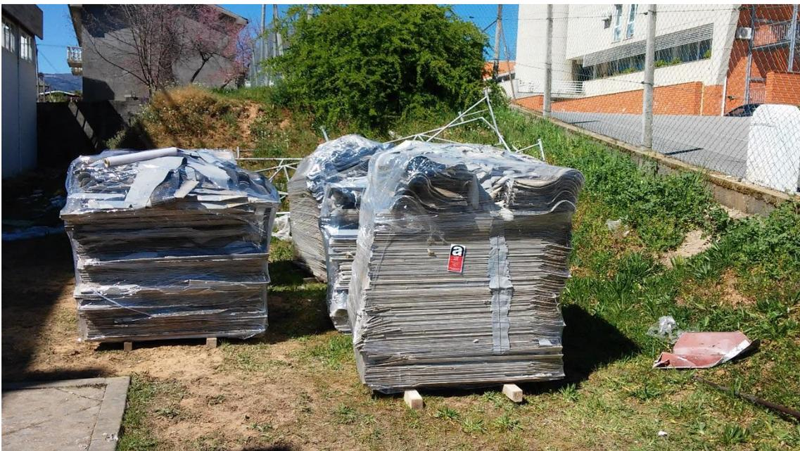
*Fotografia 86 – Chapas de fibrocimento devidamente embaladas e sinalizadas para serem transportadas para os depósitos autorizados (PGCSPM, 2015)*
