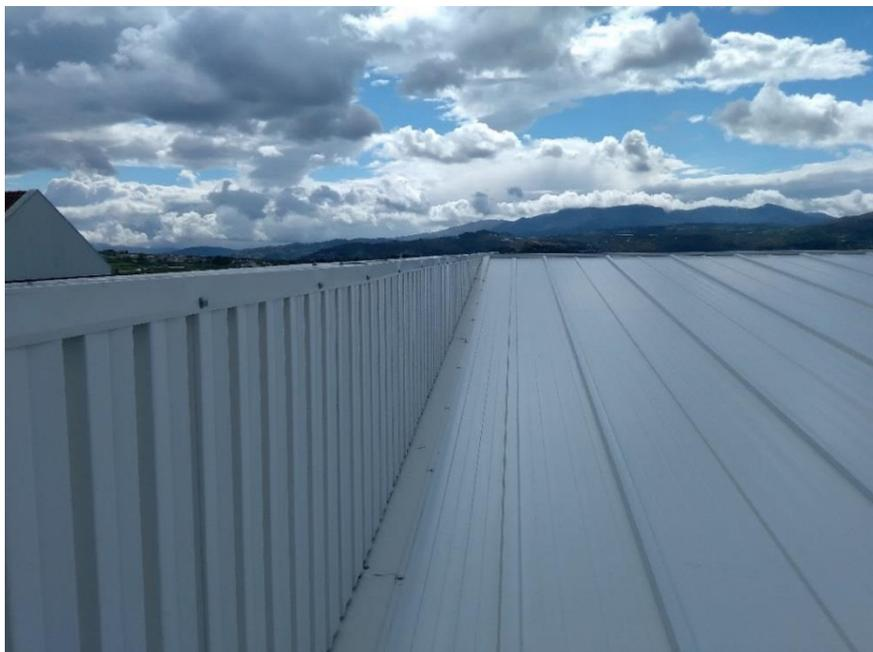
*Fotografia 89 – Ligação parede-painel sandwich (1) (PGCSPM, 2015)*
