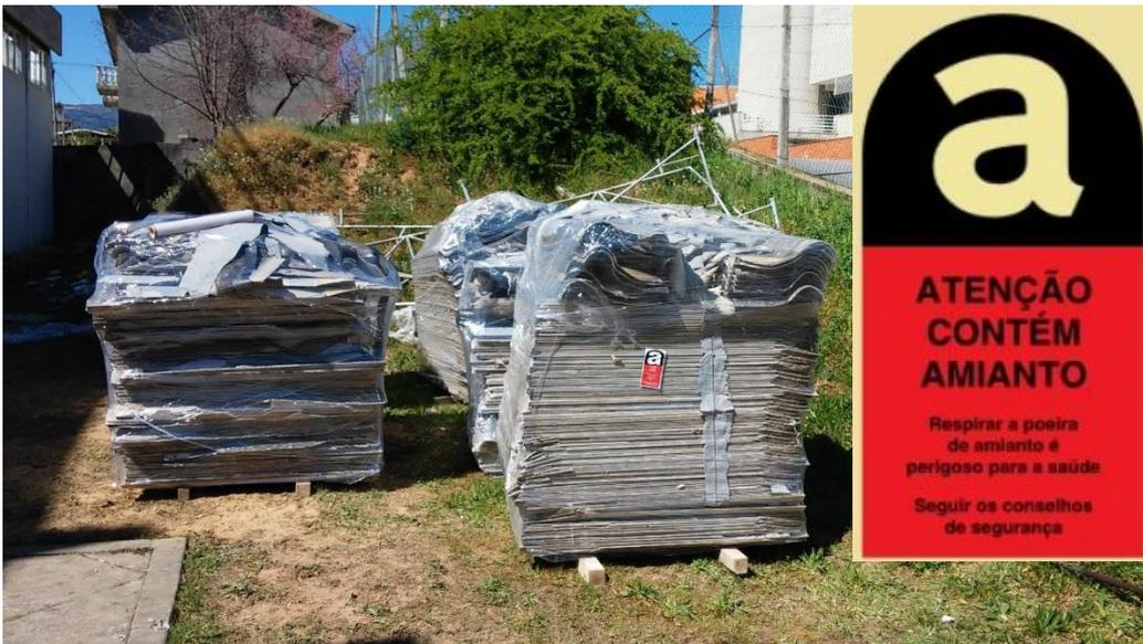
*Fotografia 24 - Paletes com placas de fibrocimento devidamente sinalizadas (PGCSPM, 2015)*
