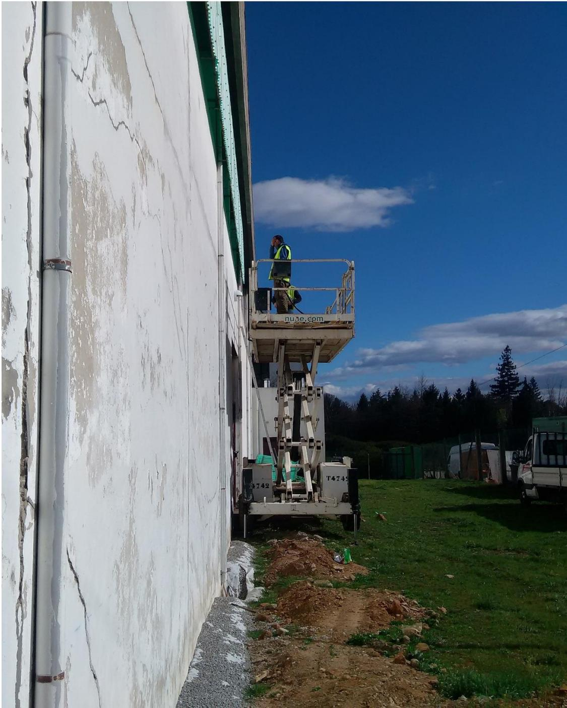
*Fotografia 77 – Instalação da plataforma de trabalho elevatória de acesso à cobertura pelo exterior (PGCSPM, 2015)*
