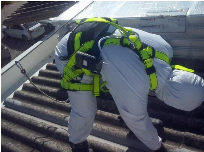
*Fotografia 28 - Trabalhador com dosímetro aplicado durante a execução dos trabalhos de remoção das placas de fibrocimento (PGCSPM, 2015)*
