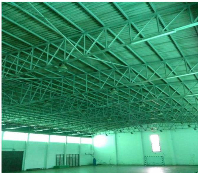
*Fotografia 39 – Cobertura em fibrocimento vista pelo interior do edifício em estudo (PGCSPM, 2014)*
