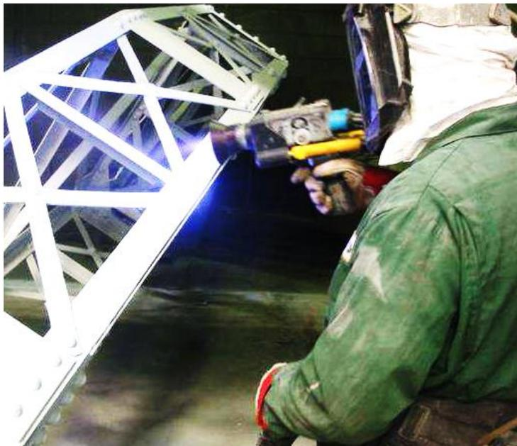
*Fotografia 21 – Metalização por projeção térmica em arco elétrico (Pereira, 2006)*
