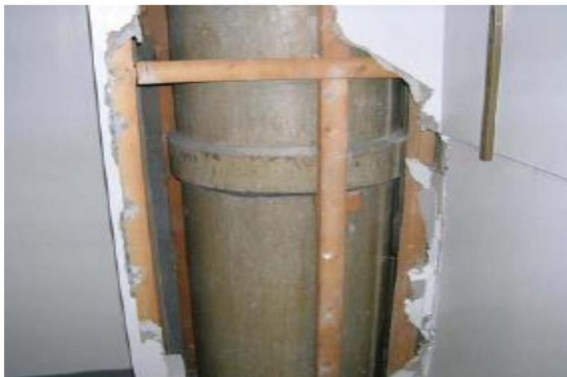
*Fotografia 12 - Conduto de fibrocimento (Guia de boas práticas para prevenir ou minimizar os riscos decorrentes do amianto, 2003)*
