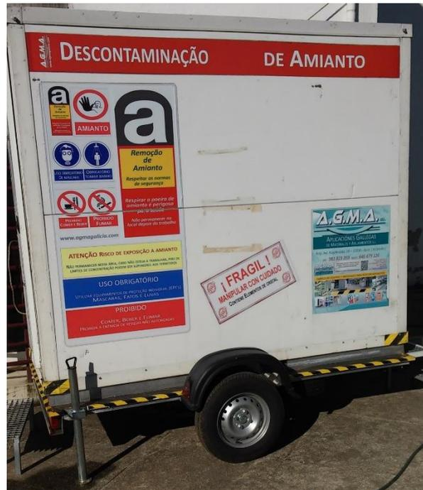
Fotografia 25 – Unidade de descontaminação dos trabalhadores envolvidos nos trabalhos de amianto (PGCSPM, 2015)
