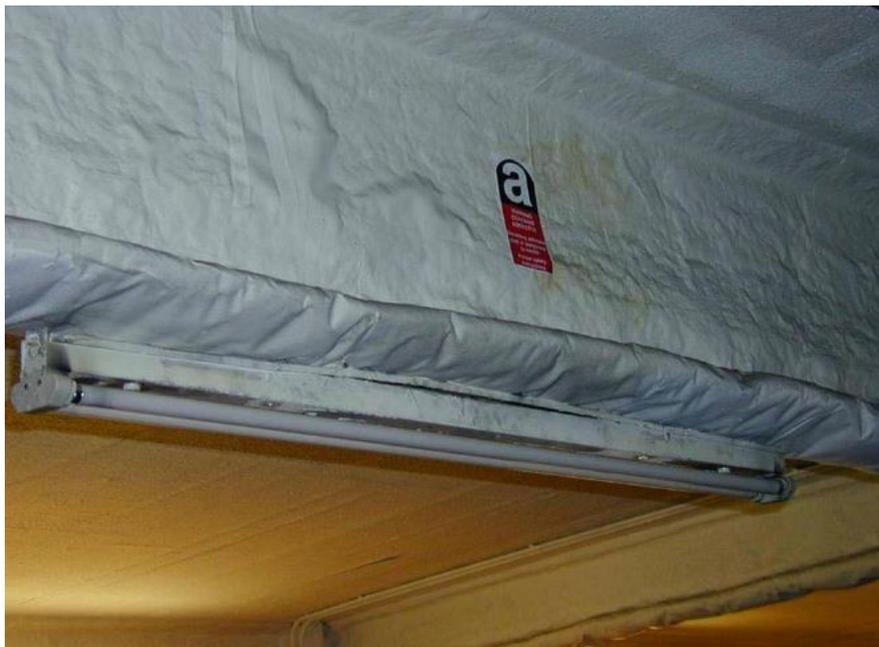
*Fotografia 18 - Estruturas de aço com isolamento de amianto (Guia de boas práticas para prevenir ou minimizar os riscos decorrentes do amianto, 2003)*
