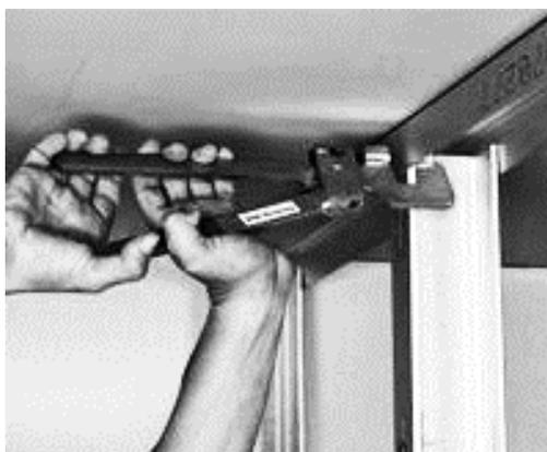
*Fotografia 14 – Cravar guia ao montante através de ferramenta própria (DRFAZTUDO, 2016)*
