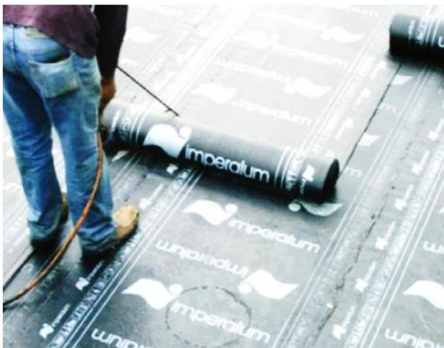
*Fotografia 69 – Aplicação de membranas de impermeabilização (Pombo, 2014)*
