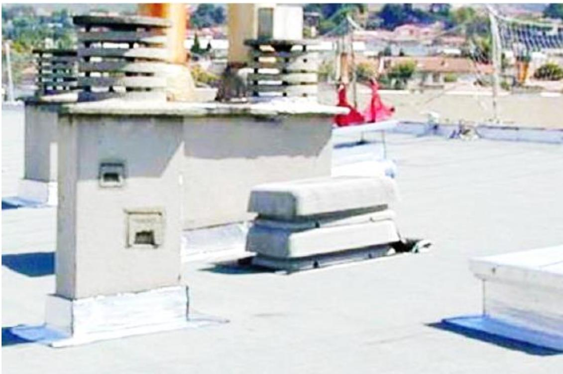
*Fotografia 70 – Adaptação a pontos singulares (Pombo, 2014)*
