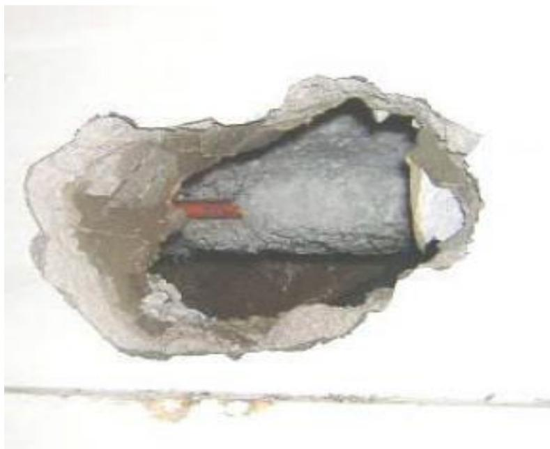
*Fotografia 15 - Tubo com isolamento de amianto (Guia de boas práticas para prevenir ou minimizar os riscos decorrentes do amianto, 2003)*
