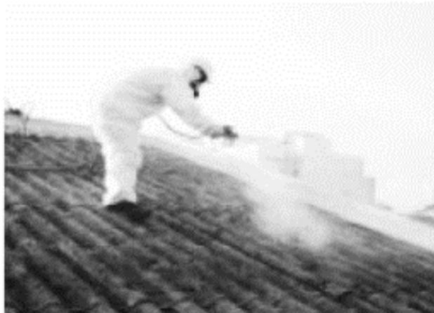
*Figura 34 - Aplicação de um aglutinante de forma a agregar as fibras de amianto com o musgo (Dias, E)*
