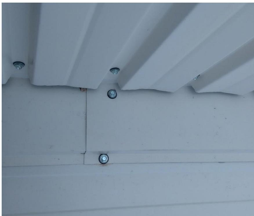
*Fotografia 90 – Ligação parede-painel sandwich (2) (PGCSPM, 2015)*
