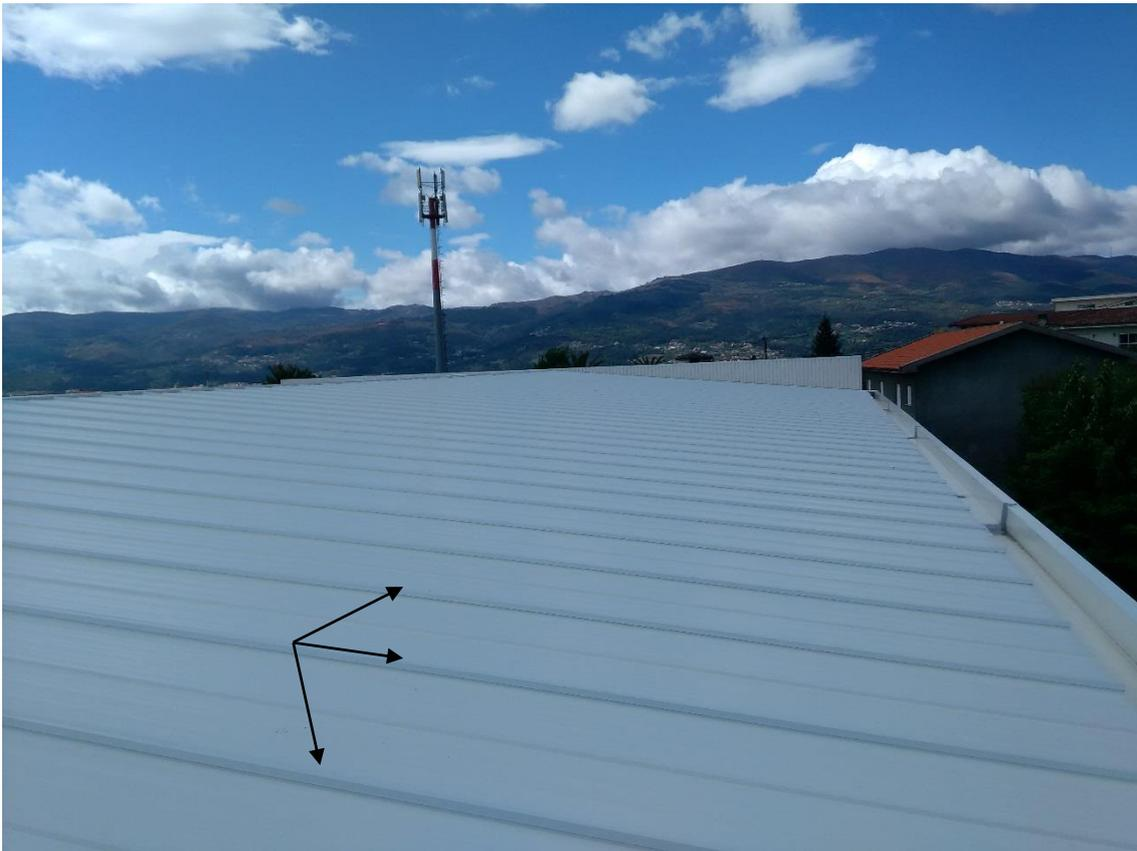
Fotografia 87 – União dos painéis *sandwich* (PGCSPM, 2015)
