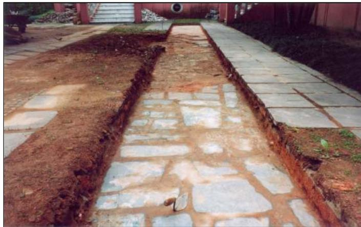
**Figura 51:** Piso de ardósia sobre calha antiga.
