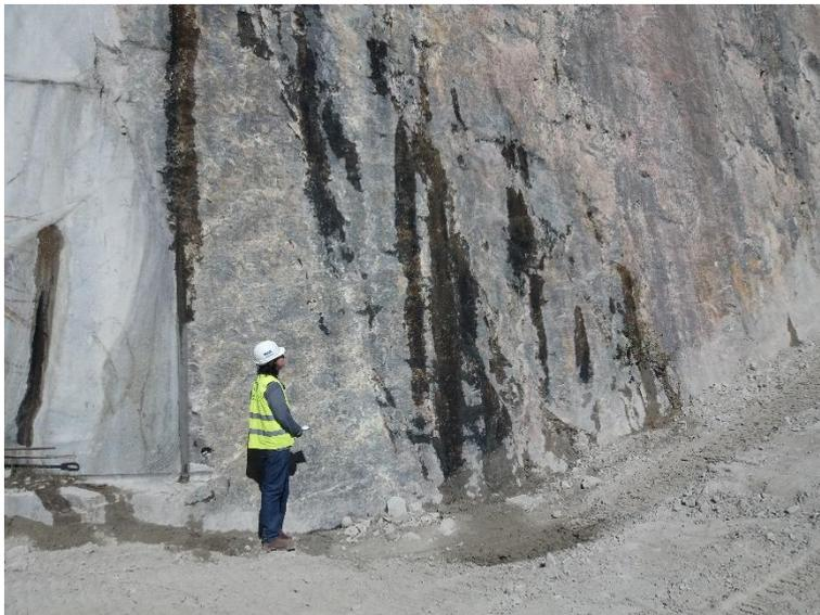
Figura 11 – Sulfuretos em parede de uma diaclase.
