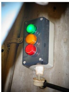
Figura 1c: Exemplo de dispositivo indicador da duração da exposição a corrente eléctrica. Fotografia de Alexandre Rodrigues
