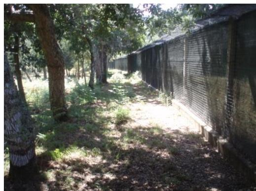
**Fotos 53, 54** - Vedação externa de um cercado com beirada de rede para o exterior e colocação de uma cerca eléctrica para evitar predadores (Fonte: Autor).
