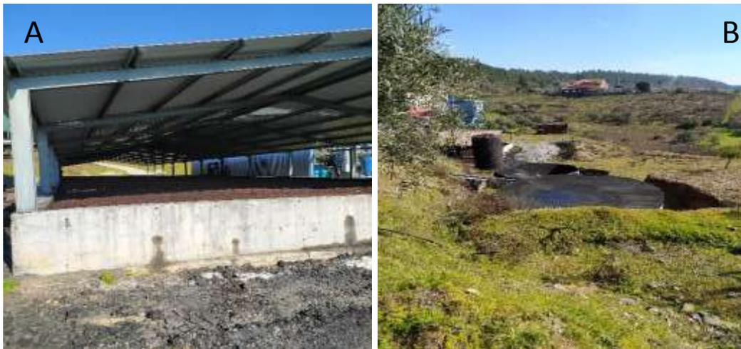
**Figura 3.3.** Tanques de retenção da CAOM (A) água ruça (B) água de lavagem da azeitona.
