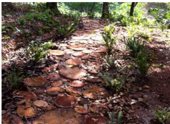
Figura 38 - Fotografia do pavimento com laminas de madeira na Ilha de Saboga. 2013
