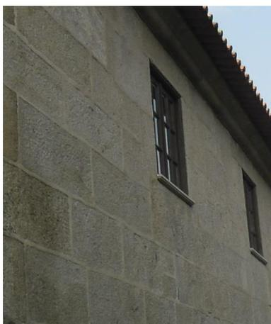
Figura 2.30 – Parede de cantaria em pedra de granito
