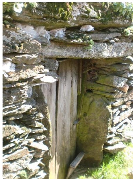
Figura 3.36 – Paredes exteriores de um edifício de pedra de xisto
