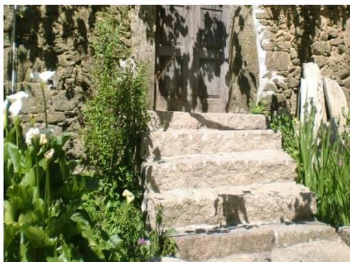
Figura 3.69 – Escadas exteriores em pedra de granito
