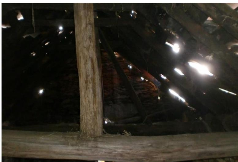
Figura 3.45 – Vista do interior de um edifício de pedra de xisto com estrutura da cobertura de madeira
