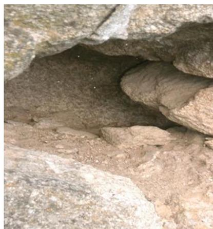
Figura 4.13 – Pormenor de enchimento de uma parede do edifício de pedra de granito do caso de estudo 2
