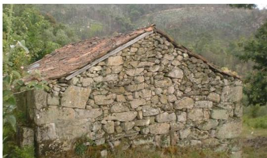
Figura 3.103 - Edifício de pedra de granito com cobertura de 2 águas
