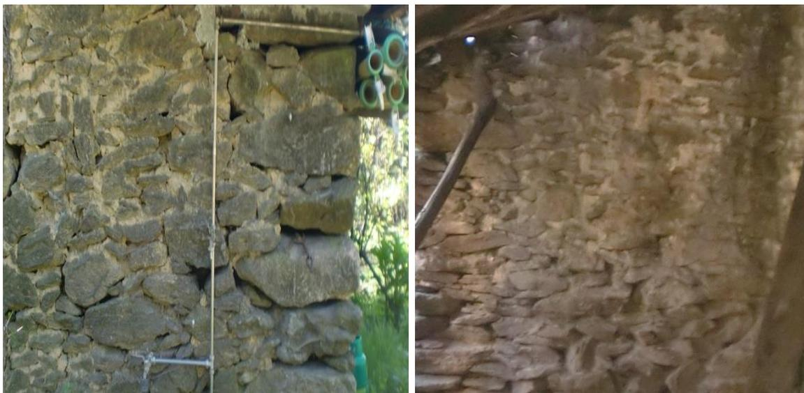
Figura 3.29 - Edifícios de pedra de xisto com material de assentamento (barro/terra)
