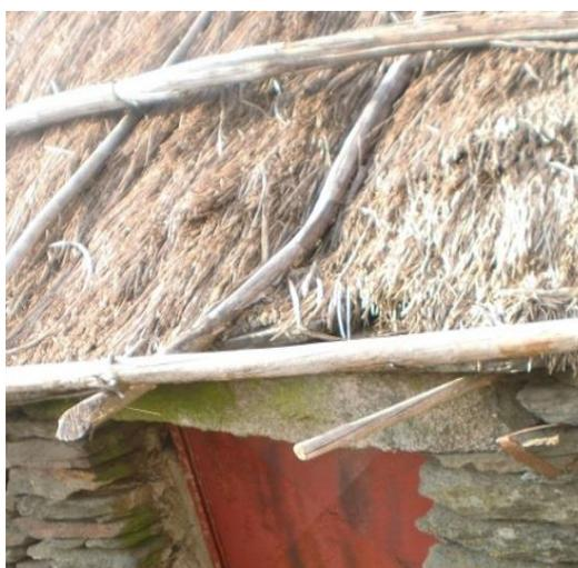
Figura 3.50 – Revestimento da cobertura em colmo
