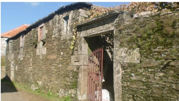
Figura 4.3 – Fachada orientada a oeste, edifício de pedra de xisto do caso de estudo 1
