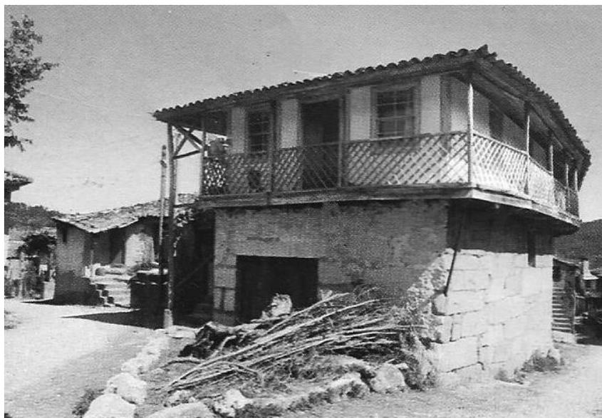
Figura 2.25 – Casa tradicional de alvenaria de pedra de granito, de varanda corrida na região Norte de Portugal [28]
