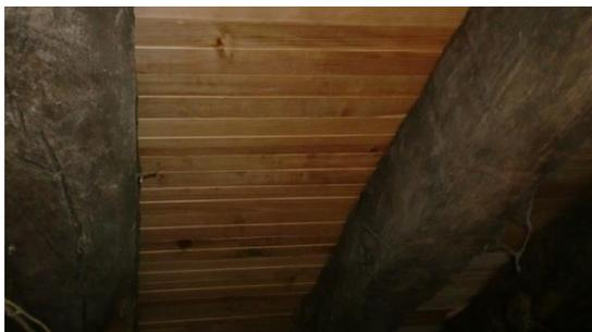
Figura 3.97 – Estrutura do pavimento de um edifício de granito em madeira
