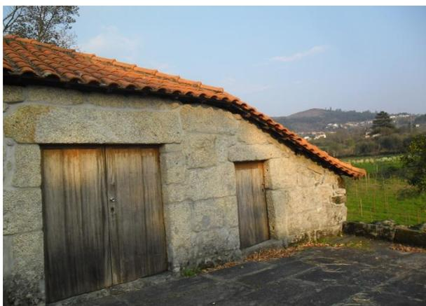
Figura 3.78 – Edifício de pedra de granito com um piso
