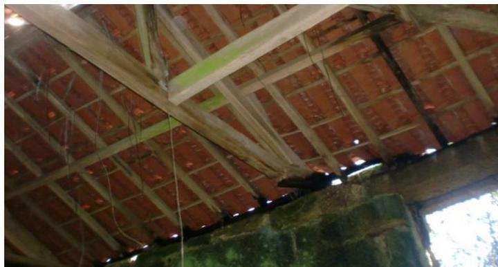
Figura 3.101 – Vista interior de um edifício de pedra de granito com estrutura da cobertura de madeira
