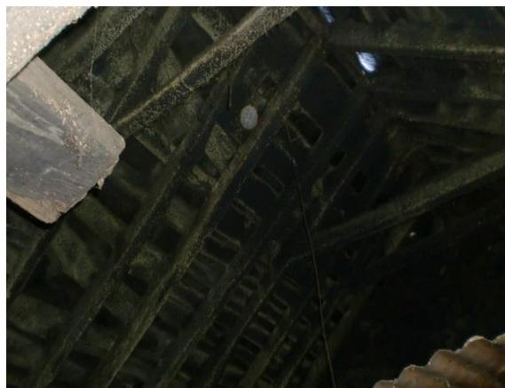
Figura 3.40 – Vista interior de um edifício sem laje de esteira horizontal
