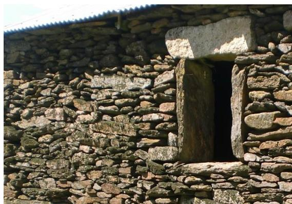
Figura 3.54 – Edifício de pedra de xisto, com xisto como elemento da ombreira e peitoril e de granito como elemento da padieira
