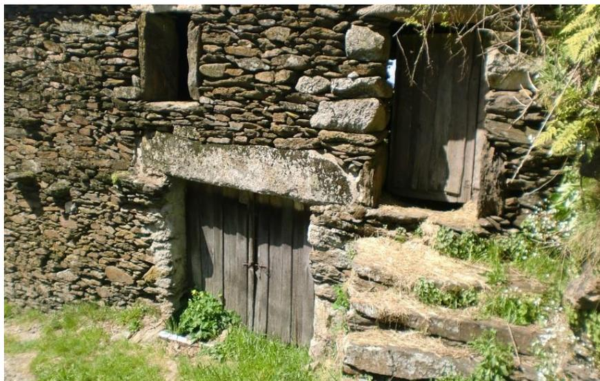
Figura 3.22 – Edifício de pedra de xisto do Tipo IV, utilizado para armazenar produções agrícolas no primeiro piso e animais no rés-do-chão
