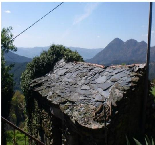
Figura 3.48 – Revestimento da cobertura em ardósia
