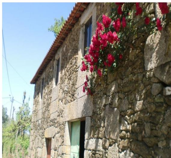
Figura 3.24 - Edifício de pedra de xisto do Tipo III, utilizado como habitação (primeiro andar) e armazém (rés-do-chão)
