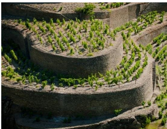
Figura 2.17 – Muros de suporte em pedra de xisto no Douro [35]
