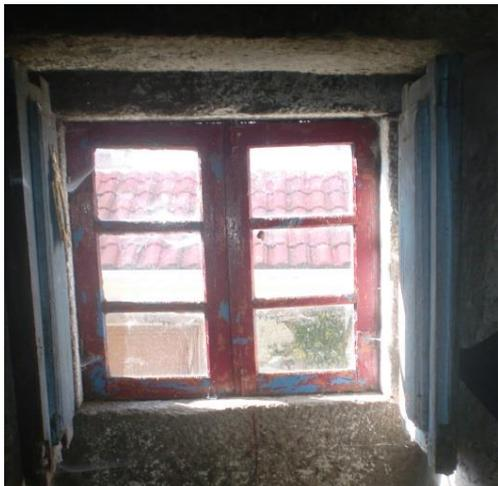
Figura 3.67 – Janela em madeira com portada interior, pertencente a um edifício de pedra de xisto
