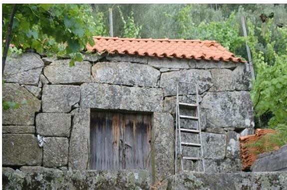
Figura 3.82 – Edifício de pedra de granito do Tipo II, armazém
