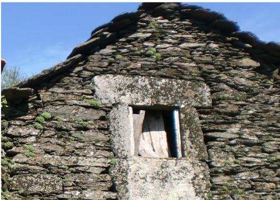
Figura 3.42 – Edifício de pedra de xisto com cobertura de 2 águas
