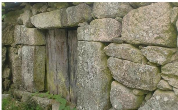
Figura 3.107 – Edifício de pedra de granito com ombreiras e padieira em granito
