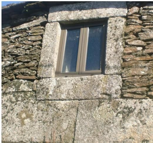
Figura 3.68 – Janela em PVC, pertencente a um edifício de pedra de xisto
