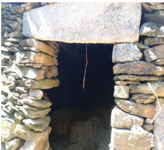
Figura 3.23 -Edifício de pedra de xisto do Tipo II, armazém
