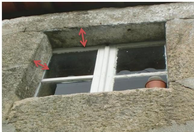
Figura 3.108 – Identificação da espessura medida no elemento da ombreira e da padieira de um edifício de pedra de granito
