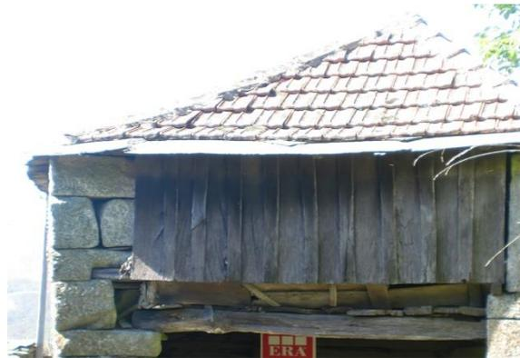
Figura 3.43 – Edifício de pedra de xisto com cobertura de 3 águas
