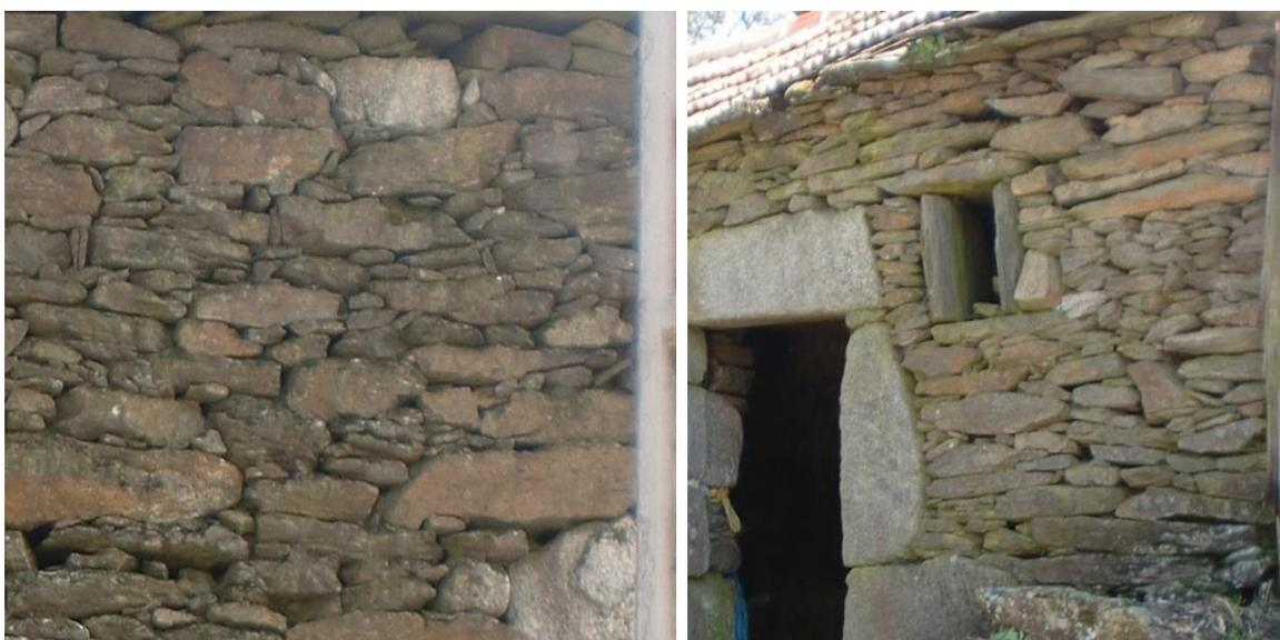
Figura 3.30 - Edifícios de pedra de xisto sem material de assentamento
