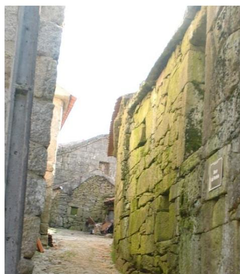
Figura 3.86 – Edifícios de pedra de granito agrupados em banda
