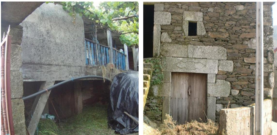
Figura 3.21 – Edifícios de pedra de xisto com utilização Tipo I, habitação com abrigo de animais no rés-do-chão
