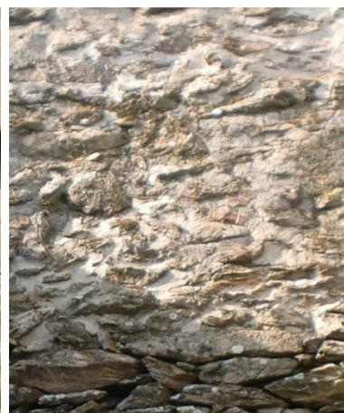
Figura 2.32 – Parede ordinária de pedra de granito
