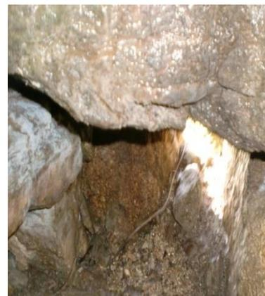
Figura 3.89 – Pormenor de parede exterior em pedra de granito com dois panos e enchimento
