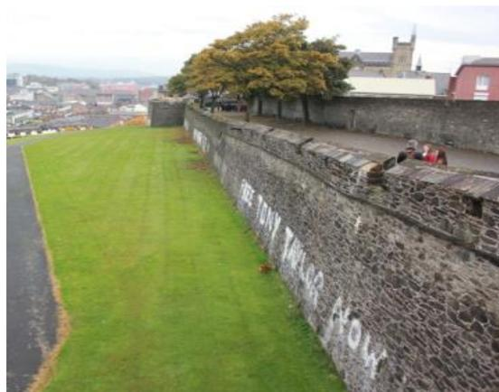
Figura 2.16 – Muralha construída em pedra de xisto na Irlanda do Norte [34]
