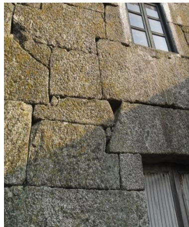
Figura 2.35 – Parede aparelhada de pedra de granito
