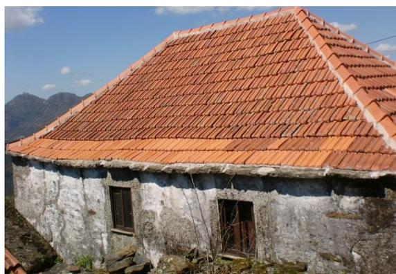
Figura 3.44 – Edifício de pedra de xisto com cobertura de 4 águas
