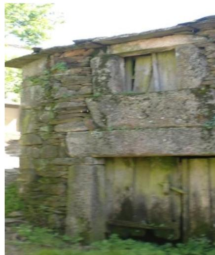
Figura 3.19 - Edifício de pedra de xisto com dois pisos
