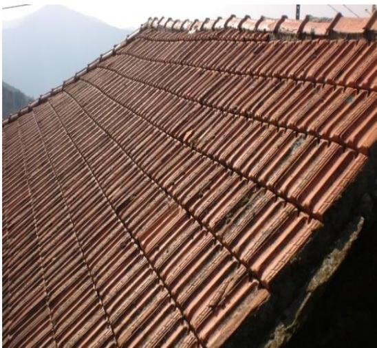
Figura 3.47 – Revestimento da cobertura em telha cerâmica
