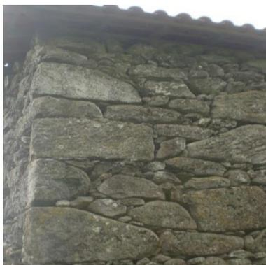
Figura 3.106 – Edifício de pedra de granito com cunhais em granito
