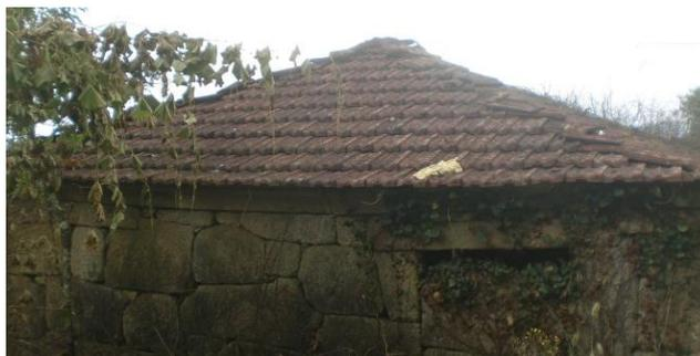
Figura 3.105 - Edifício de pedra de granito com cobertura de 4 águas
