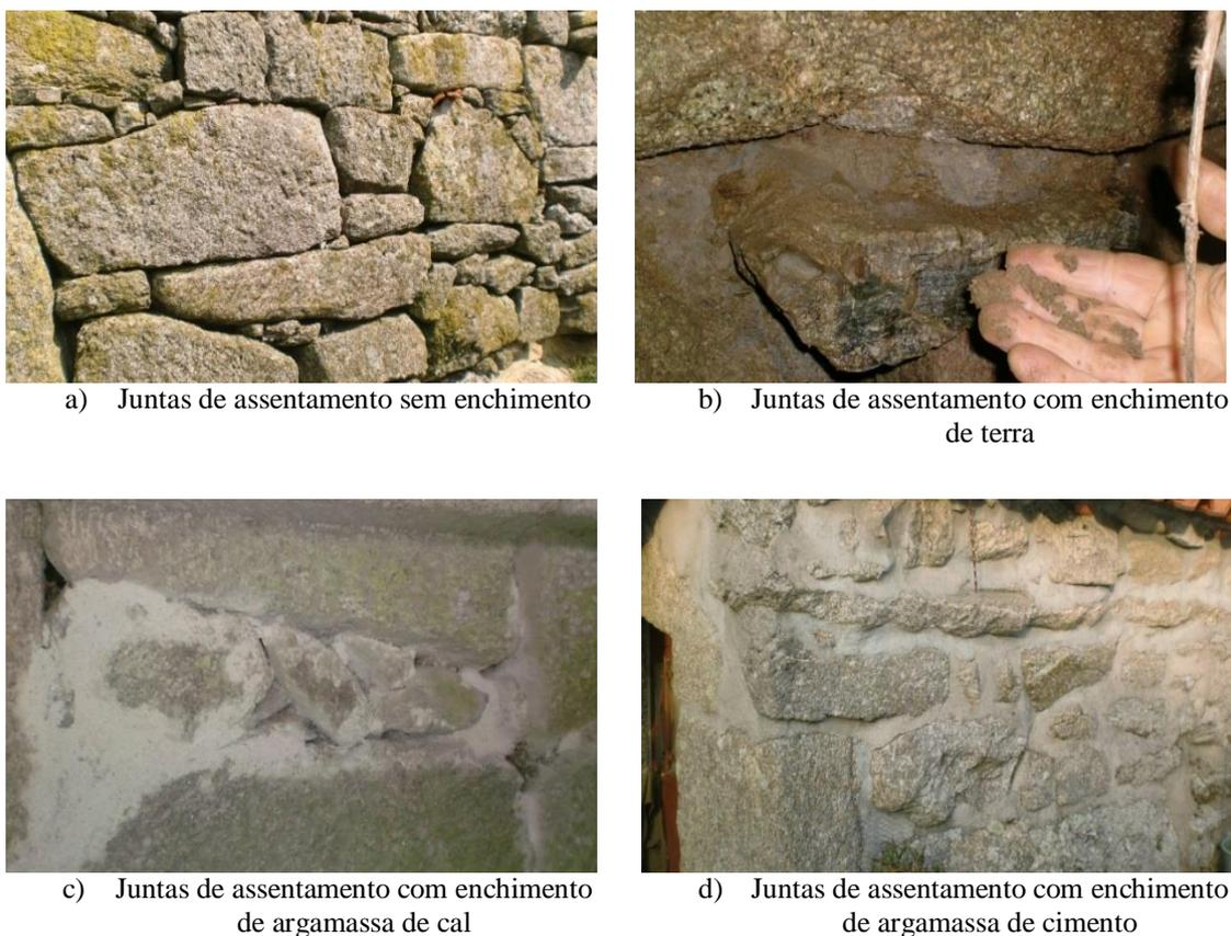
Figura 3.91 – Exemplos de paredes com diferentes materiais de enchimento nas juntas de assentamento
