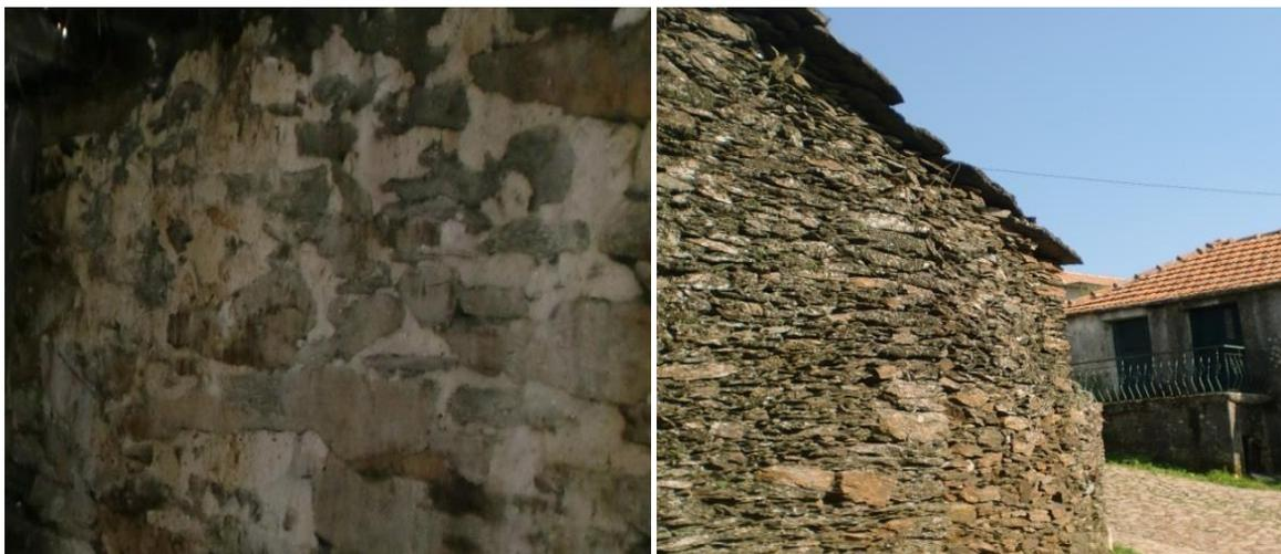
a) Juntas com enchimento de um material terroso pelo interior do edifício
