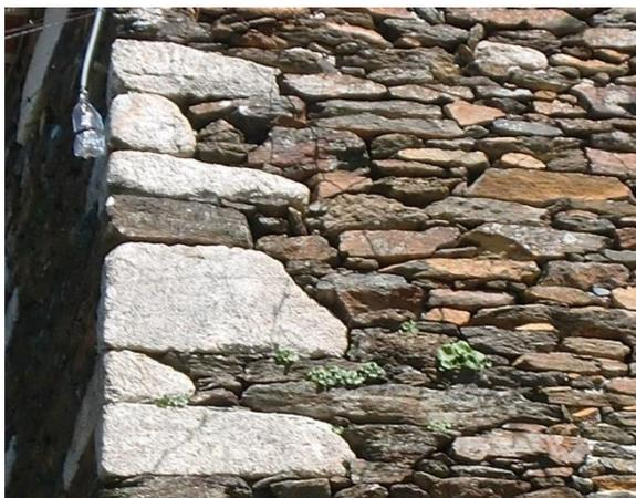
Figura 3.51 - Edifício de pedra de xisto com cunhais em granito
