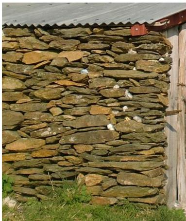
Figura 2.33 – Parede de alvenaria de xisto em pedra seca
