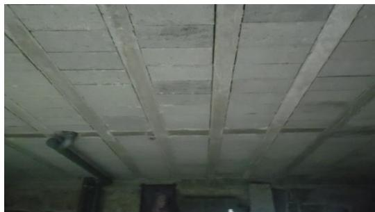
Figura 3.98 – Estrutura do pavimento de um edifício de granito em blocos de betão
