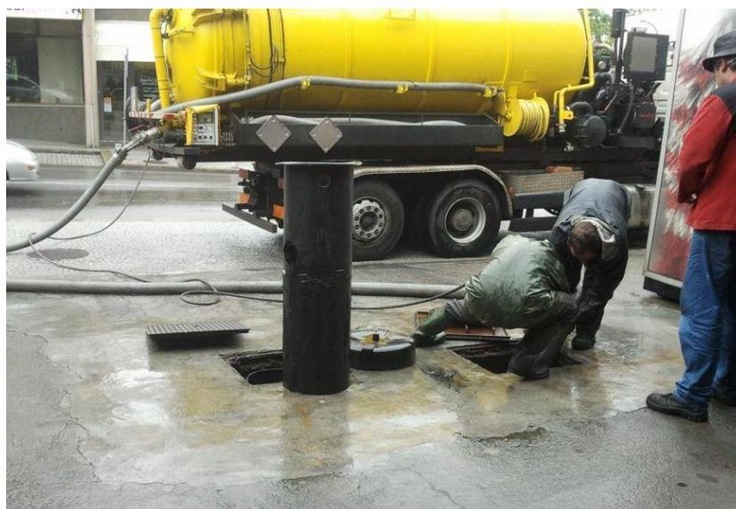
**Figura 25 - Limpeza dos separadores de lamas e hidrocarbonetos**
