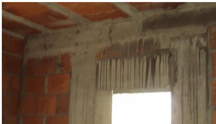
*Figura 15 - Três pontes térmicas (interior) – pilares; viga; caixa de estore*
