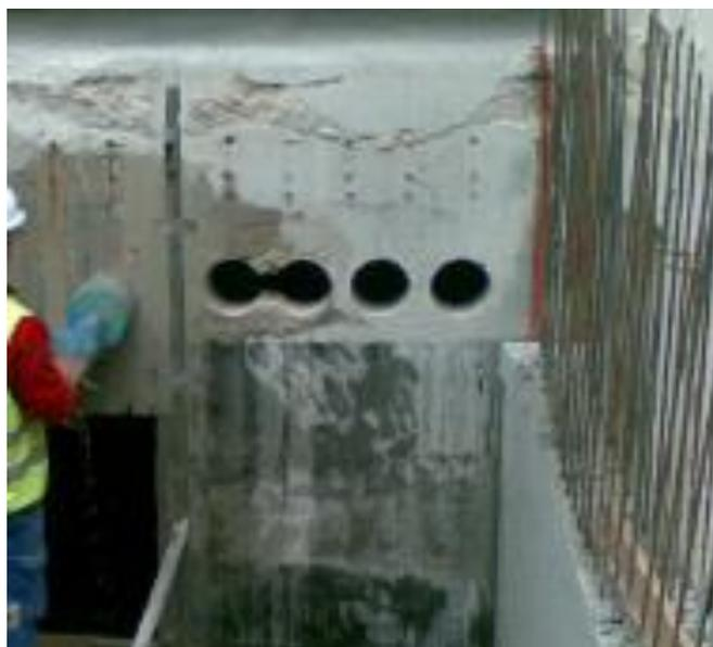
*Figura 8 - Extração de carotes cilíndricos.
