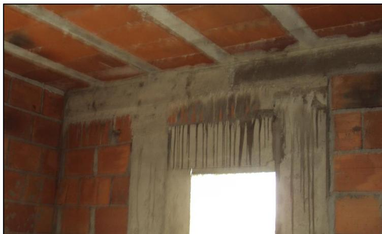
*Figura 47 - Zonas de ligação de elementos estruturais suscetível de fendilhação*
