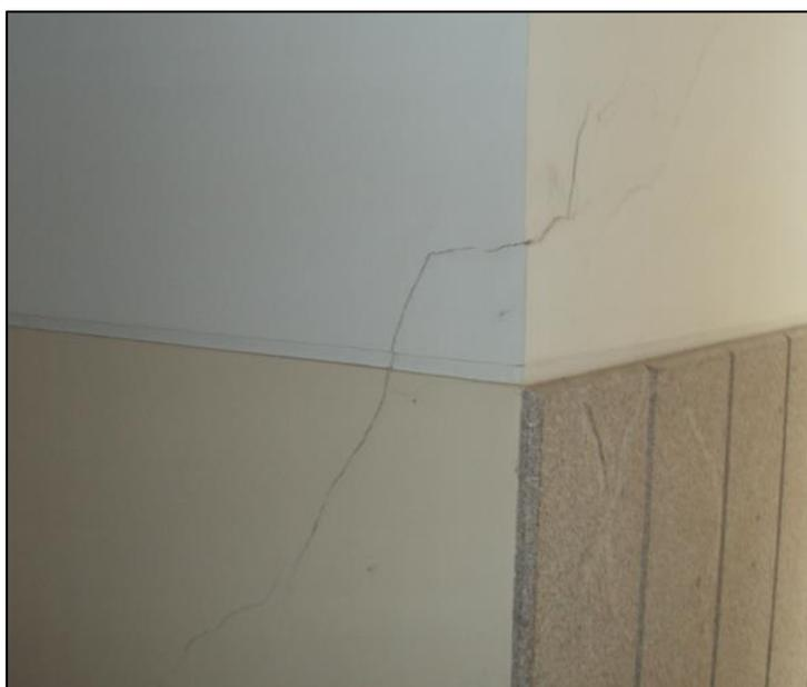
*Figura 64 - Separação na parede interior virada para a caixa de escadas.*
