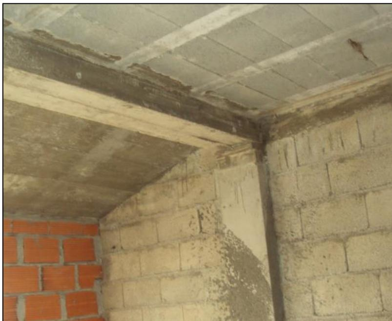
*Figura 49 - Zonas de ligação de elementos estruturais suscetível de fendilhação*
