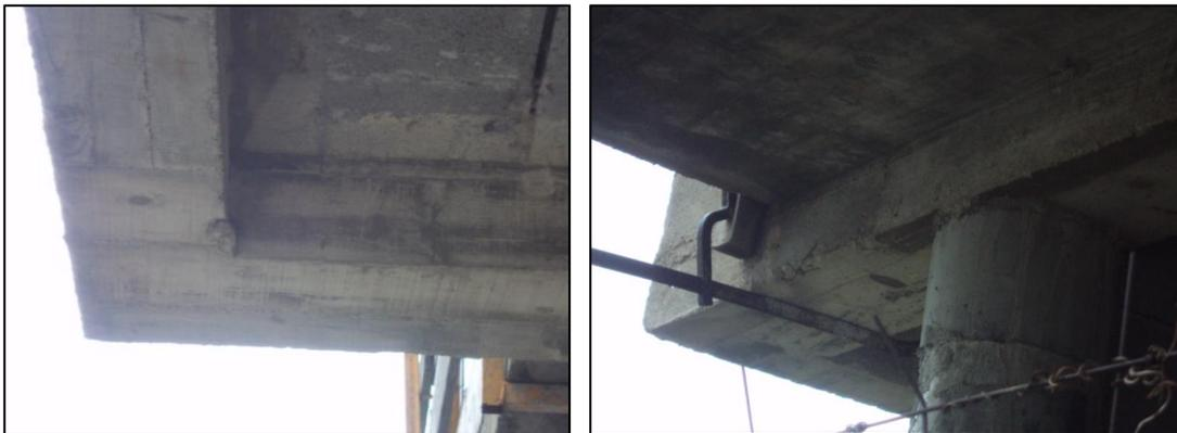
*Figura 46 - Zonas de ligação de elementos estruturais suscetível de fendilhação*
