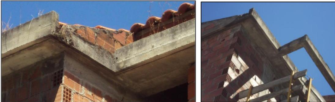
*Figura 48 - Zonas de ligação de elementos estruturais suscetível de fendilhação*
