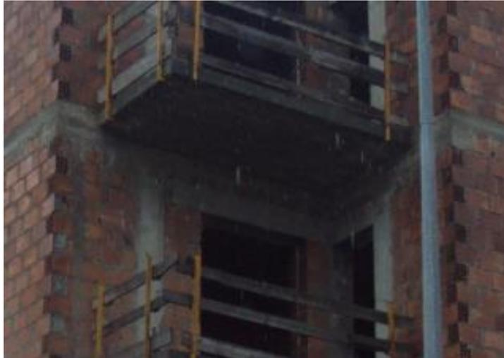
*Figura 16 - Três pontes térmicas (exterior) – pilares; viga; caixa de estore*
