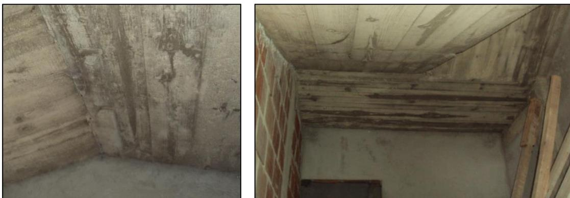
*Figura 50 - Zonas de ligação de elementos estruturais suscetível de fendilhação*
