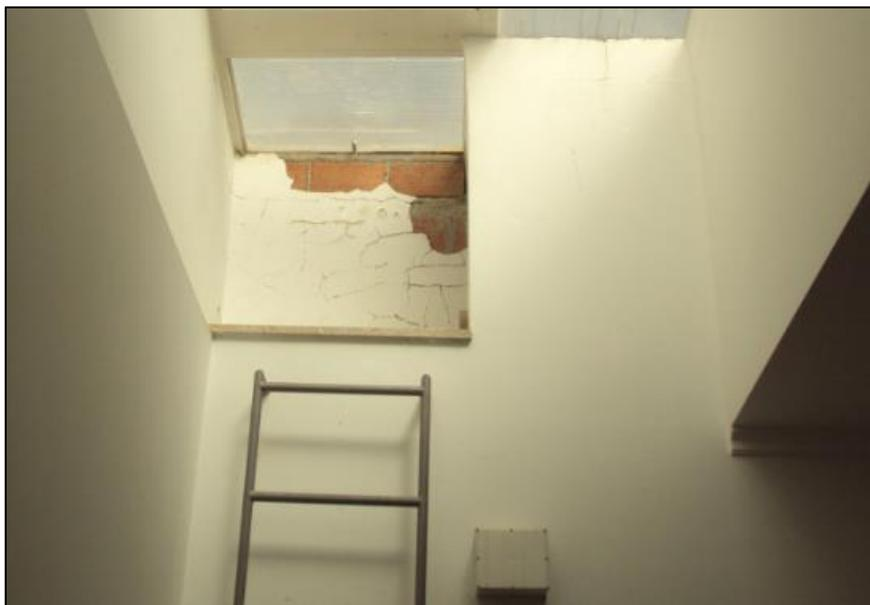
*Figura 65 - destacamento do revestimento na parede junto á claraboia.*
