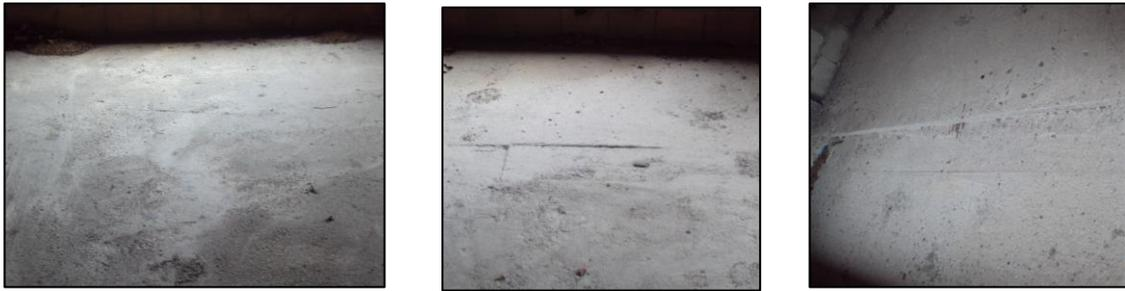
*Figura 45 - Zonas de ligação de elementos estruturais suscetível de fendilhação*
