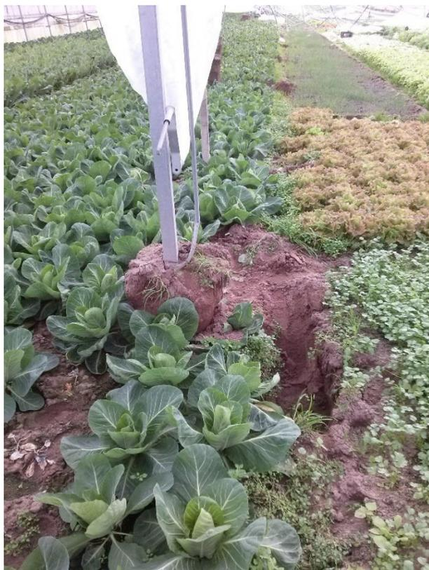
Figura 41- Sapata da estufa levantada pela ação de um tornado, na Freguesia da Estela, Concelho da Póvoa de Varzim, a 10.02.2014 (Fonte: Autor)
