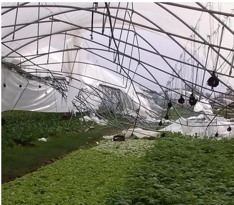
Figura 40 – Estufa completamente destruída por um tornado (Fonte:Autor)
