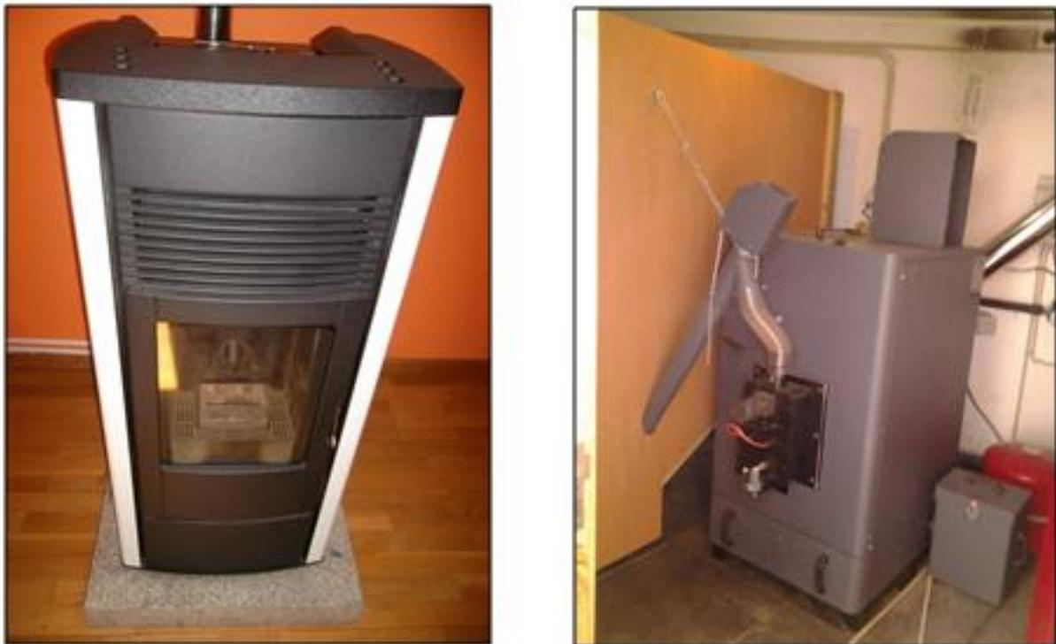
Figura 8 – Foto de uma salamandra à esquerda e de uma caldeira à direita (Concelho de Boticas, 2013).
