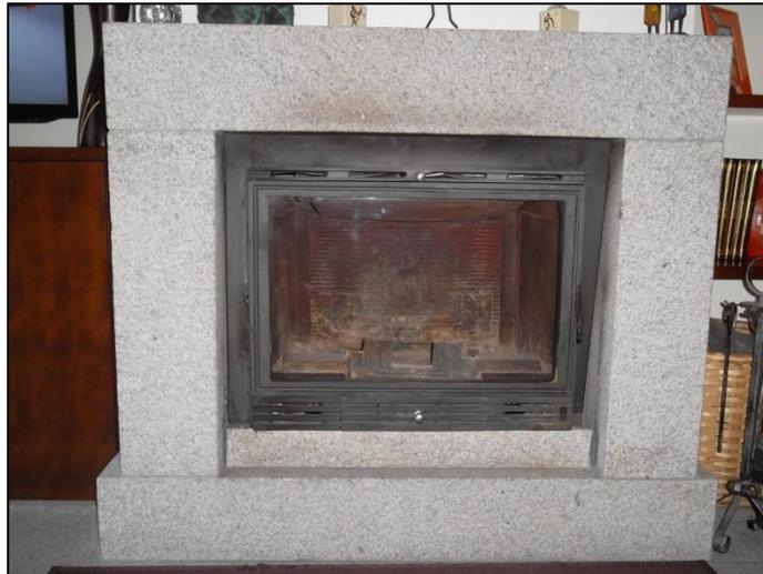
**Figura 5 – Foto recuperador de calor (Concelho de Boticas, 2013).**
